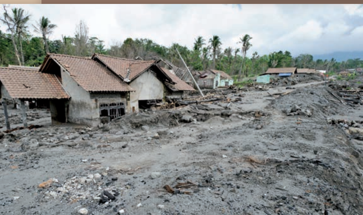
Destrucción causada por material volcánico arrojado por el volcán Merapi, isla de Java, Indonesia.
