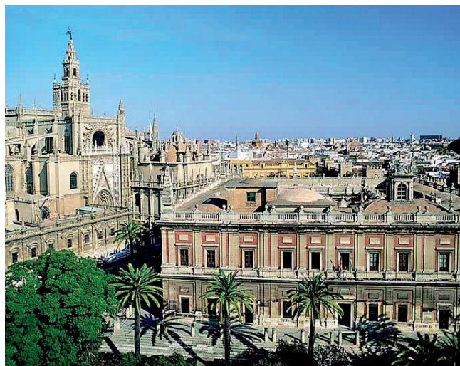
En este edificio ubicado en Sevilla, España funcionó la Casa de Contratación de Sevilla.
