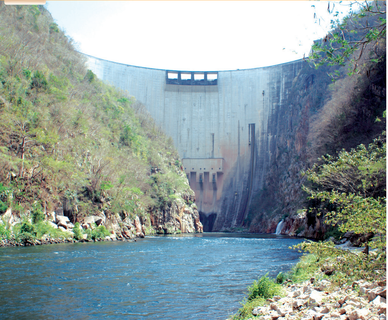
Represa hidroeléctrica General Francisco Morazán. (El Cajón)
